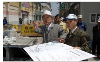
67 공유 정종득 목포시장 BTL공사 현장… 2009-04-22 최정호
