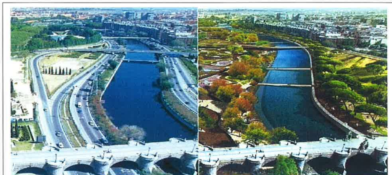
M-30 도로 개설 전(좌) 후(우)-도로를 지하화후 기존도로 공간에 녹지 조성
