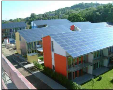
△ 지붕에 태양열 패널 설치
