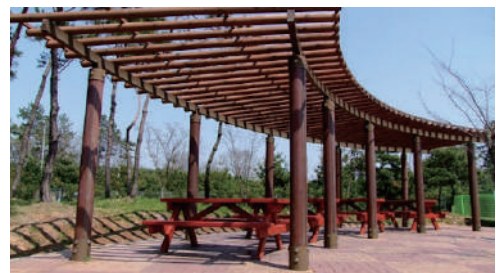
권장 공간의 특성을 활용한 퍼걸러 설치
