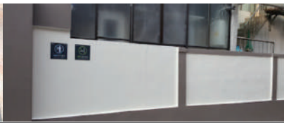
· 노후 외벽 재도색
