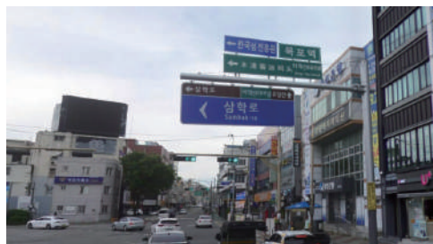
지양 혼잡한 교통안내시설
