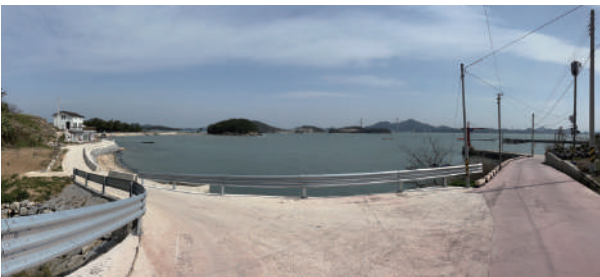
지양 노후되고 단절된 도로
