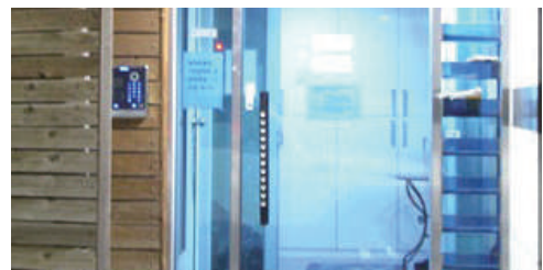
권장 출입구의 보안시설 설치
