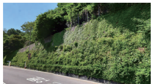
권장 다단식 식재 옹벽 설치
