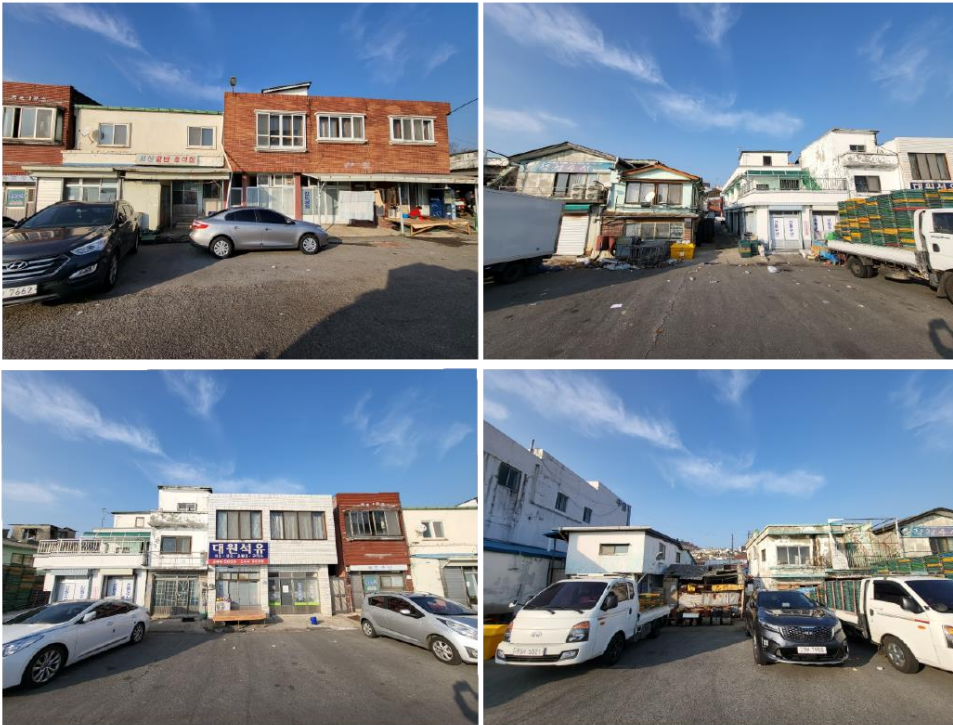
건축물 일부 철거 및 리모델링
